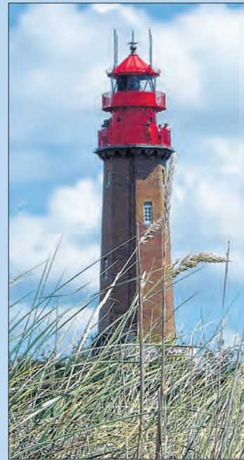
Erst 2011 frisch restauriert: der Leuchtturm von Flügge.
